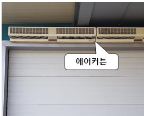
외부 출입문에 에어커튼 설치
